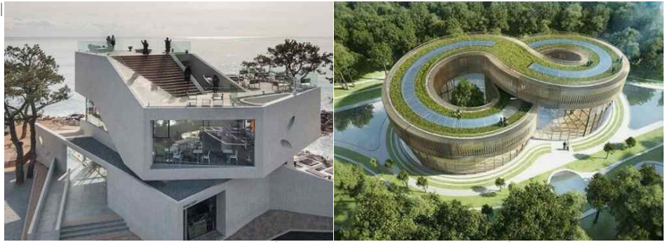
건축물 외관 관리(외관색상통일, 옥상녹화, 벽면녹화)
