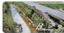
하천 제방 유실
